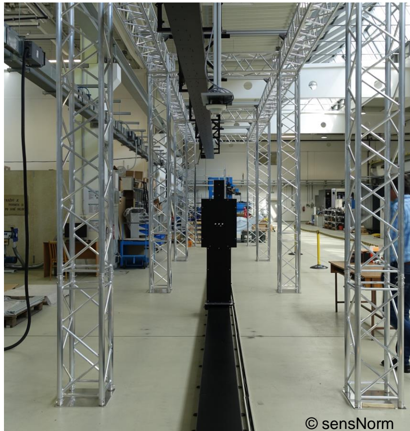
Vorarbeiten für den Aufbau einer Messanlage für normierte Messungen nach sensNORM
