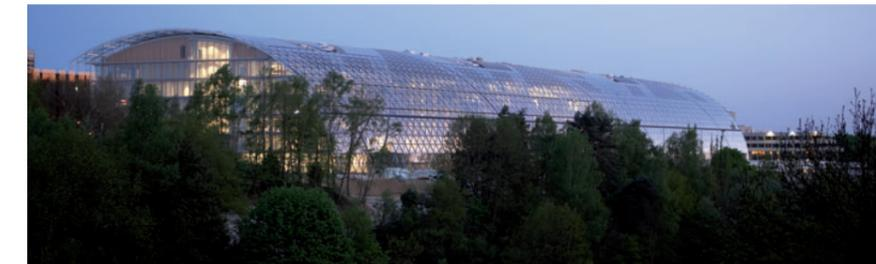
statt, die das Öffnen von Fenstern zur natürlichen Belüftung zum Atrium selbst im Winter erlaubt. Zweitens wurde erst durch die Abschirmung direkter Witterungseinflüsse wie Regen und Wind der Einbau von großflächigen Holzfassaden und -fenstern möglich. Dies führt nicht nur zu einer höheren Behaglichkeit, sondern im Vergleich zu Standard-Aluminiumfassaden auch zu einer Reduzierung der ansonsten benötigten Primärenergie.
